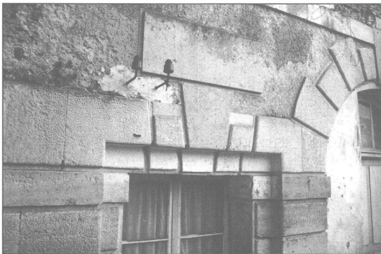
Fig. 14 - Détail de la porte de la galerie. (Cliché C. Corvisier).
